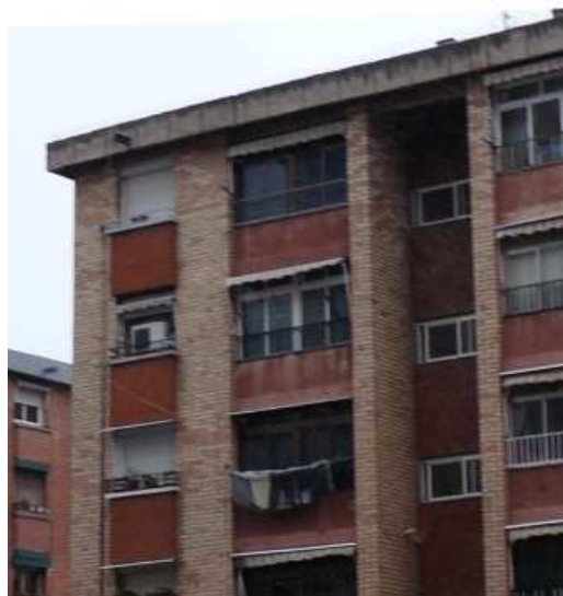
Figura 15.- Bloque 1 C/Conflent 2, 4. Fachada oeste. Pérdidas en encuentro vertical Fuente.- CENER
