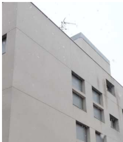
Figura 30.- Edificio Calle Moli 1,3 Pérdidas en canto de forjados y carpinterías Fuente.- CENER
