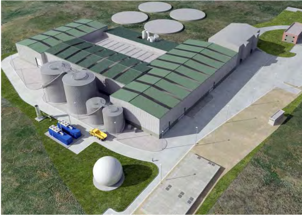
Figura 39- Planta comarcal de compostatge a Granollers
